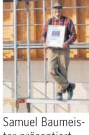
Samuel Baumeister präsentiert den Baufortschritt seiner Gestaltungswerkstatt.
